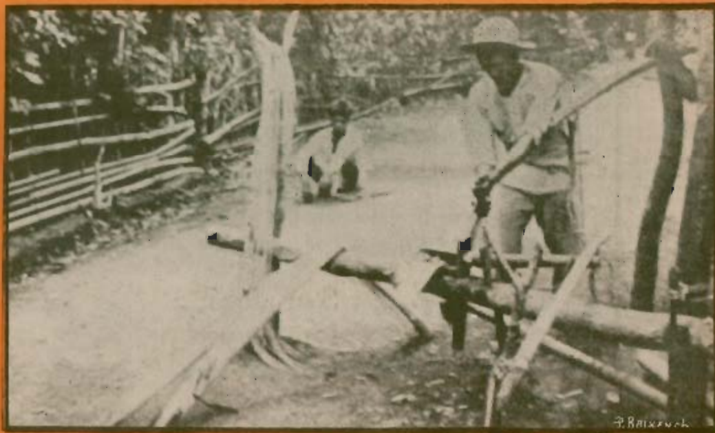
Sistema primitivo, aun en uso, para obtener la fibra de Abacá o Cáñamo de Manila, cuya descripción se encuentra en el Capítulo respectivo de esta Revista.
